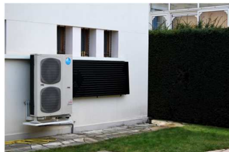
Couplage PAC-solaire thermique (crédits AirPAC & Sun et al., 2014)
